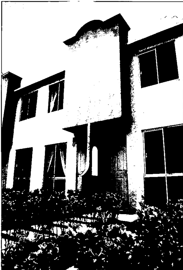
Real del Valle (Acolman, Estado de México)
