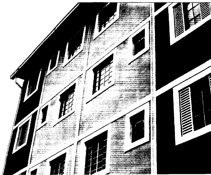
Conjunto habitacional construído com a tecnologia Usiteto em Timóteo, MG
