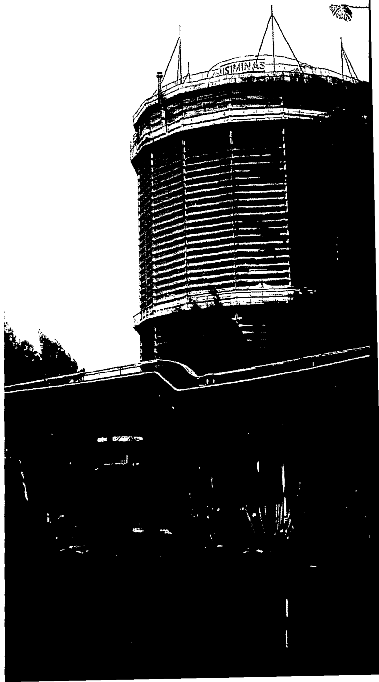
Área interna da Usina Intendente Câmara
