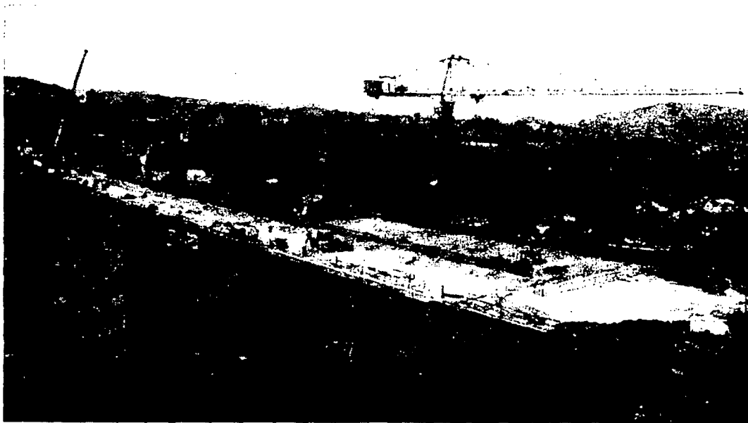
A10 - Bucelas/Carregado/IC3 Motorway
