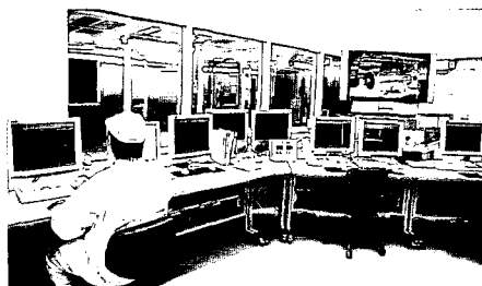
コンピュータで自動制御・省人化された管制室
