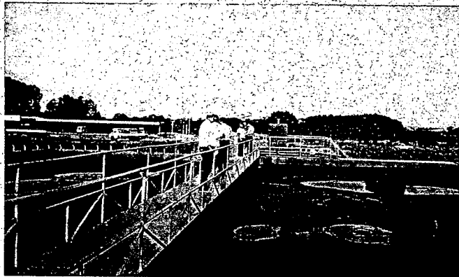
Estação de tratamento de efluentes - Pouso Alegre - MG
