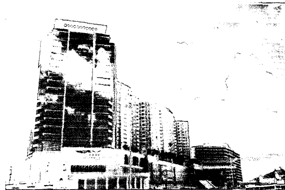
為紅磡國際都會安裝電力設備
