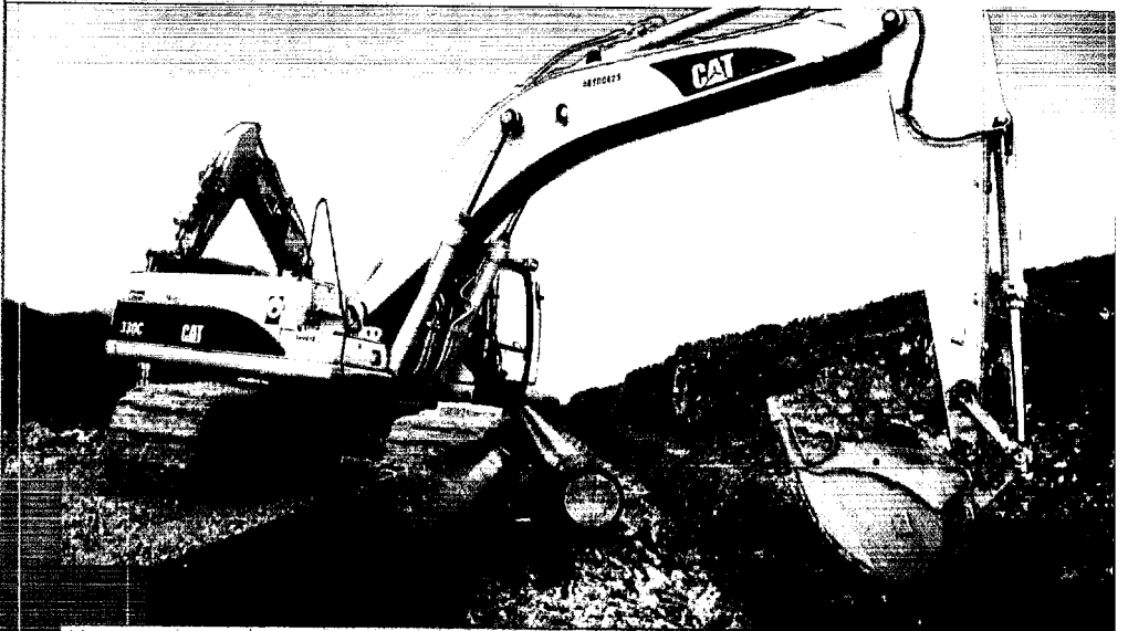
Excavadora CAT abriendo zanjas para el gasoducto de Caimán
