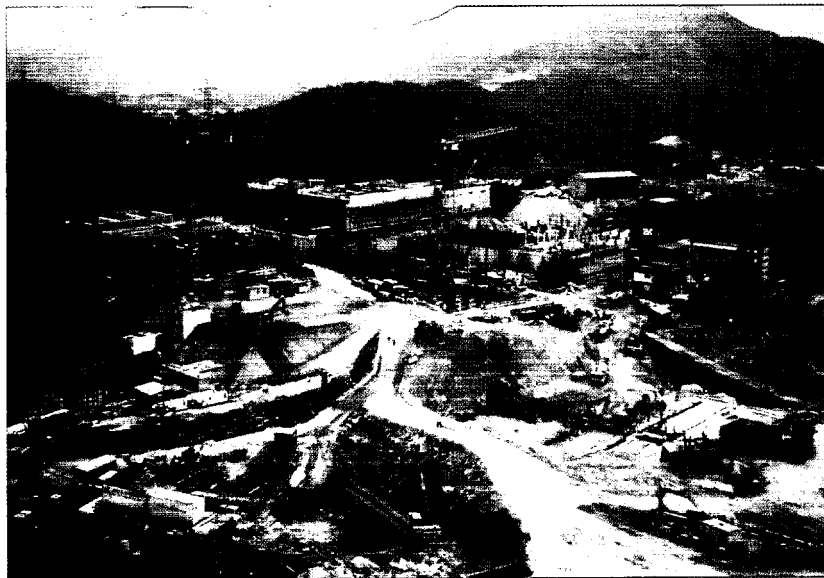
為水務署興建大埔自來水處理廠及泵房
