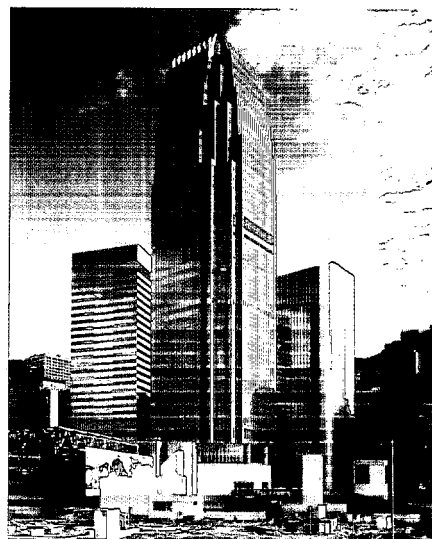
為中環國際金融中心設計、供應及安裝鋁窗工程
