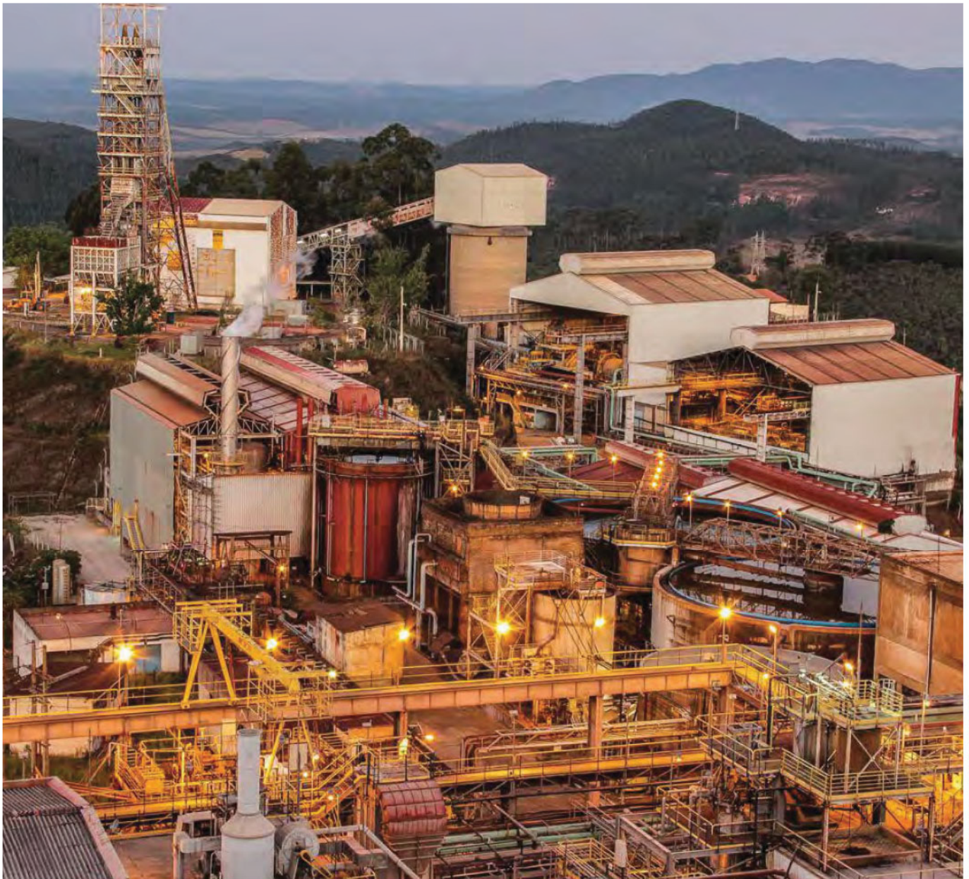
View of the sulphide plant at Córrego do Sítio
